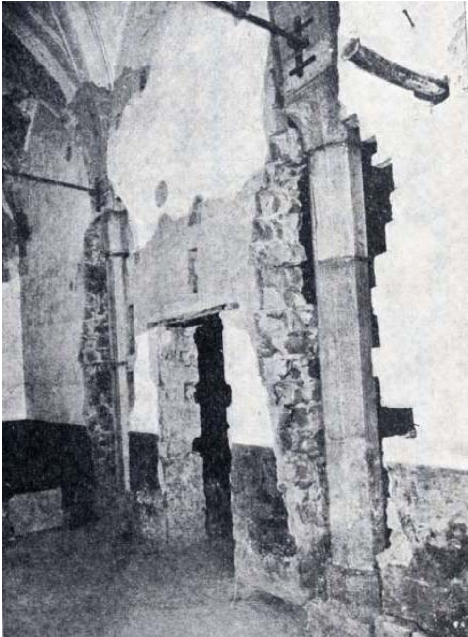
S. Maria Donnaregina, chiesa trecentesca, basilica inferiore durante i lavori di restauro, 1928
