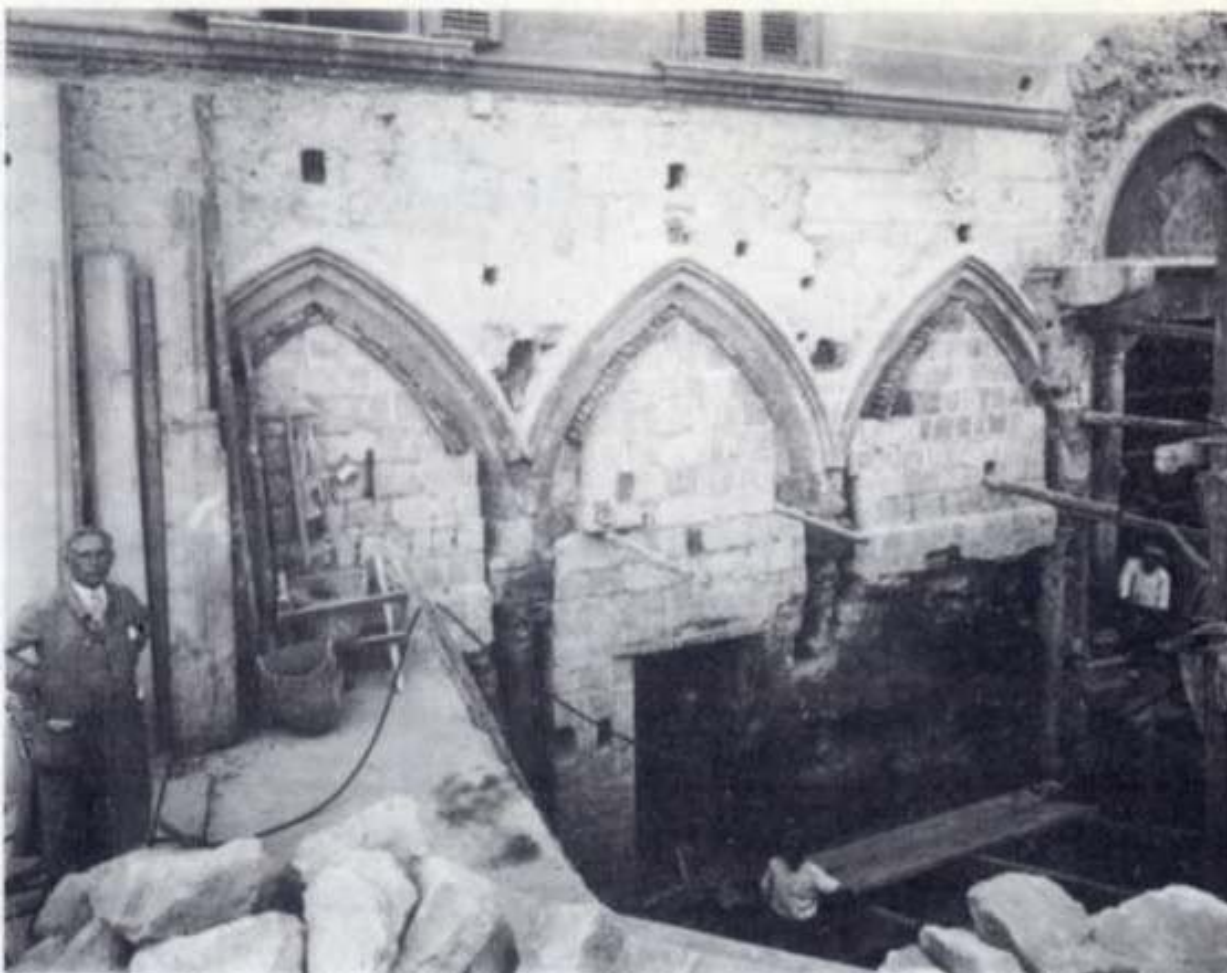
S. Maria Incoronata, fasi di liberazione e restauro del portico esterno
