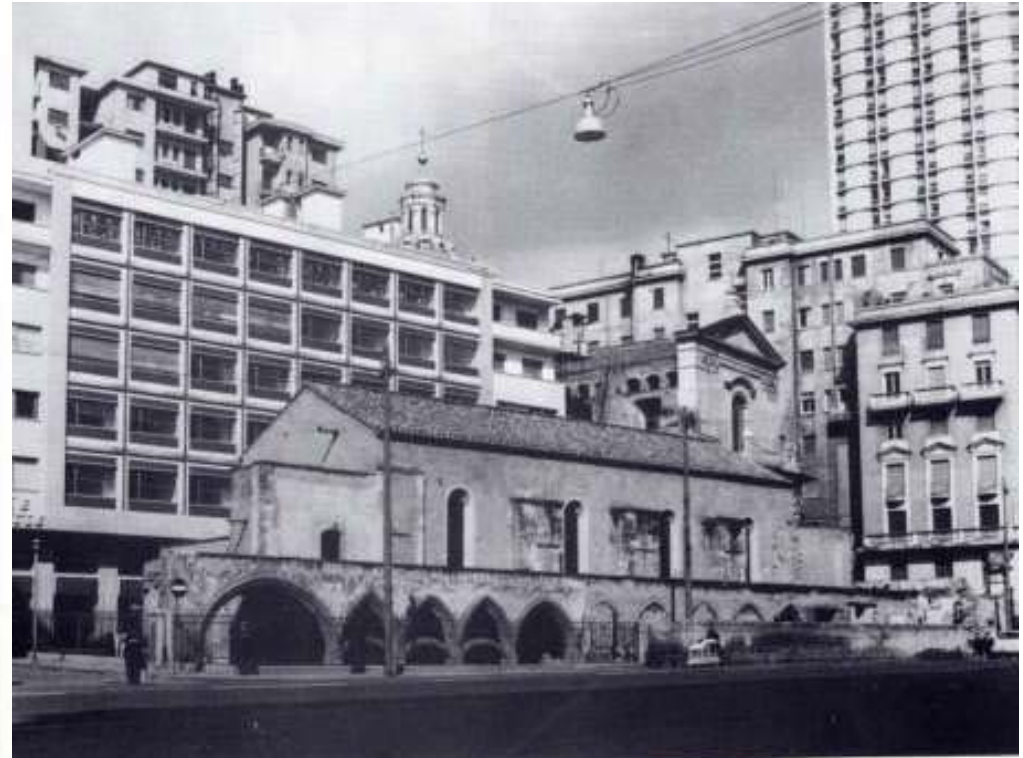
S. Maria Incoronata, particolare della chiesa dopo la demolizione dell'edificio sovrastante
